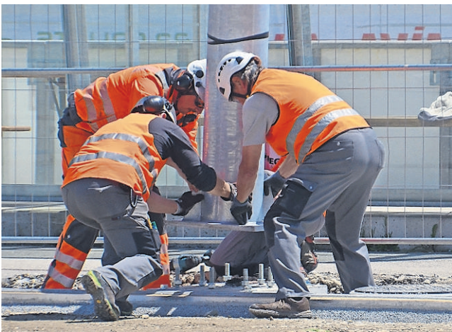
Der Lichtmast wird in den vorbereiteten Sockel eingepasst.
